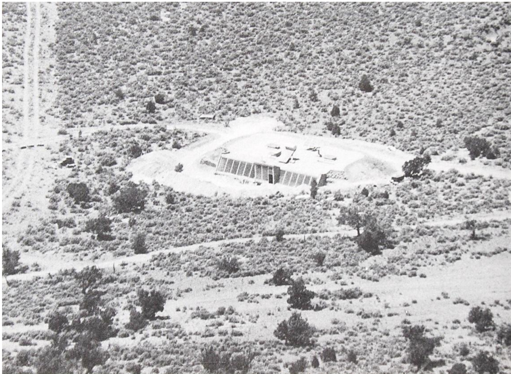
NAVETIERRA GENÉRICA EN S.T.A.R., EN CONSTRUCCIÓN
